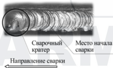
Рис. 9.4. Начало сварки при смене электрода.
